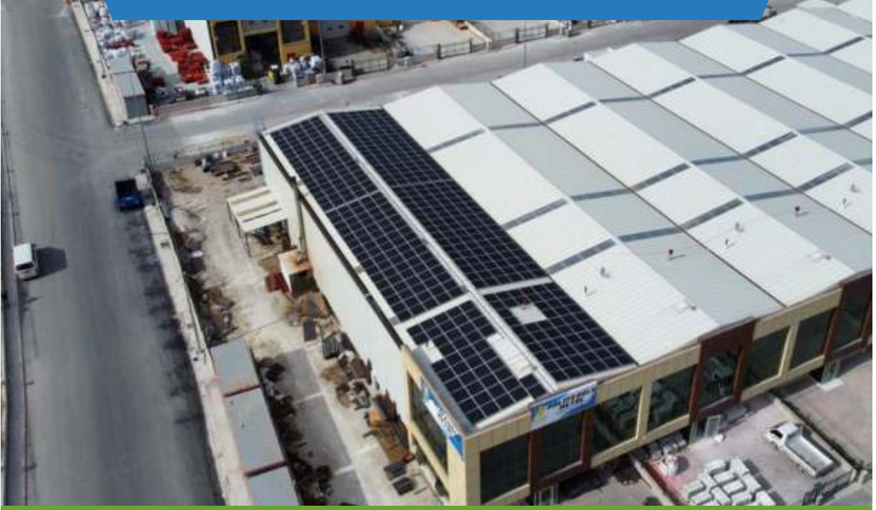
Akın Traktör | 289 kWp | KONYA - Selçuklu
