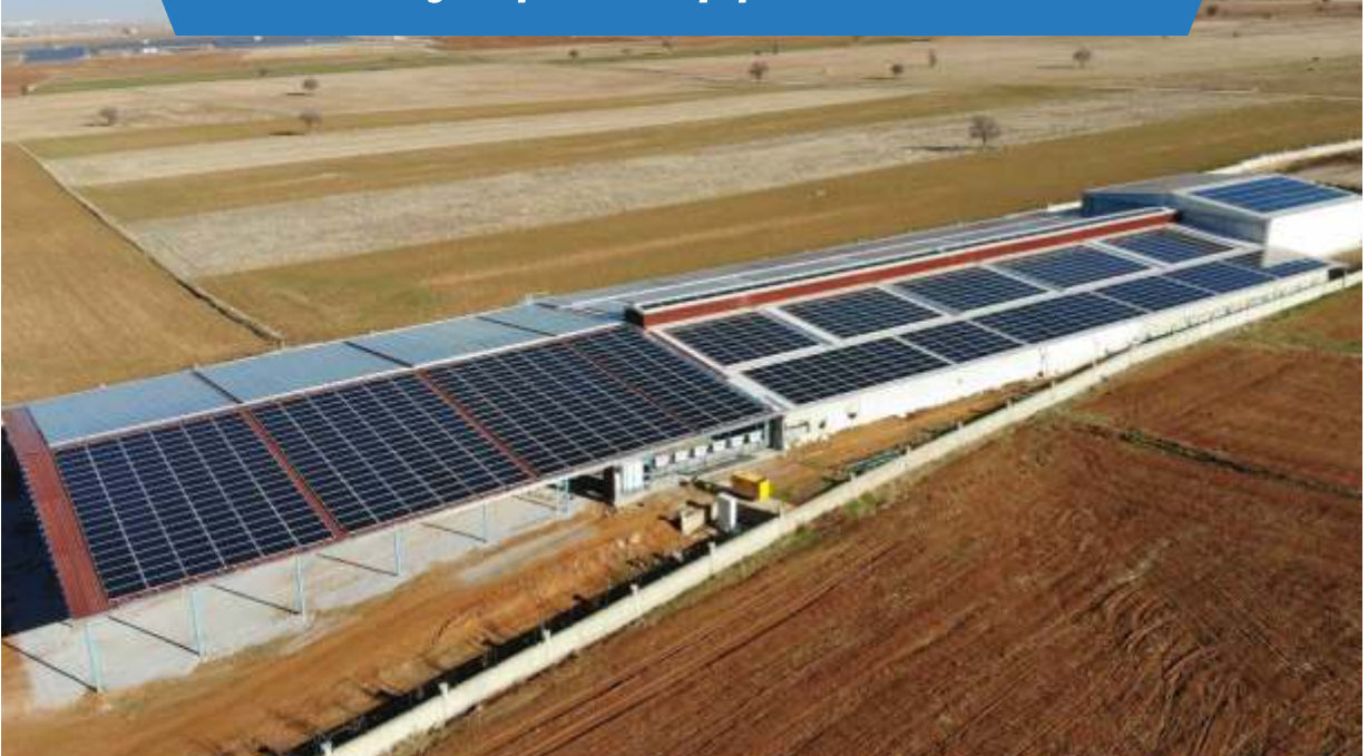
Hak İnovasyon | 790 kWp | KONYA - Kadınhanı
