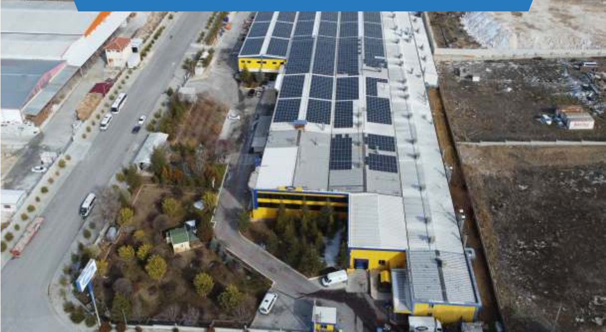
Som Ambalaj 2 | 857 kWp | KARAMAN - Merkez
