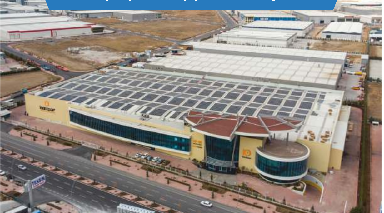
Kentpar | 1820 kWp | KONYA - Selçuklu
