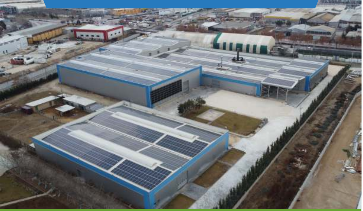
Köroğlu Kauçuk | 1800 kWp | KONYA - Selçuklu
