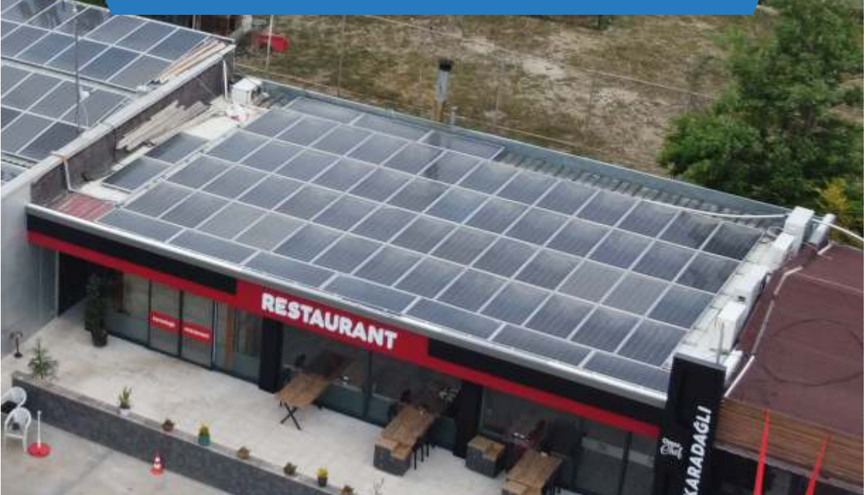
Karadağlı Restoran | 35 kWp | KARAMAN - Merkez
