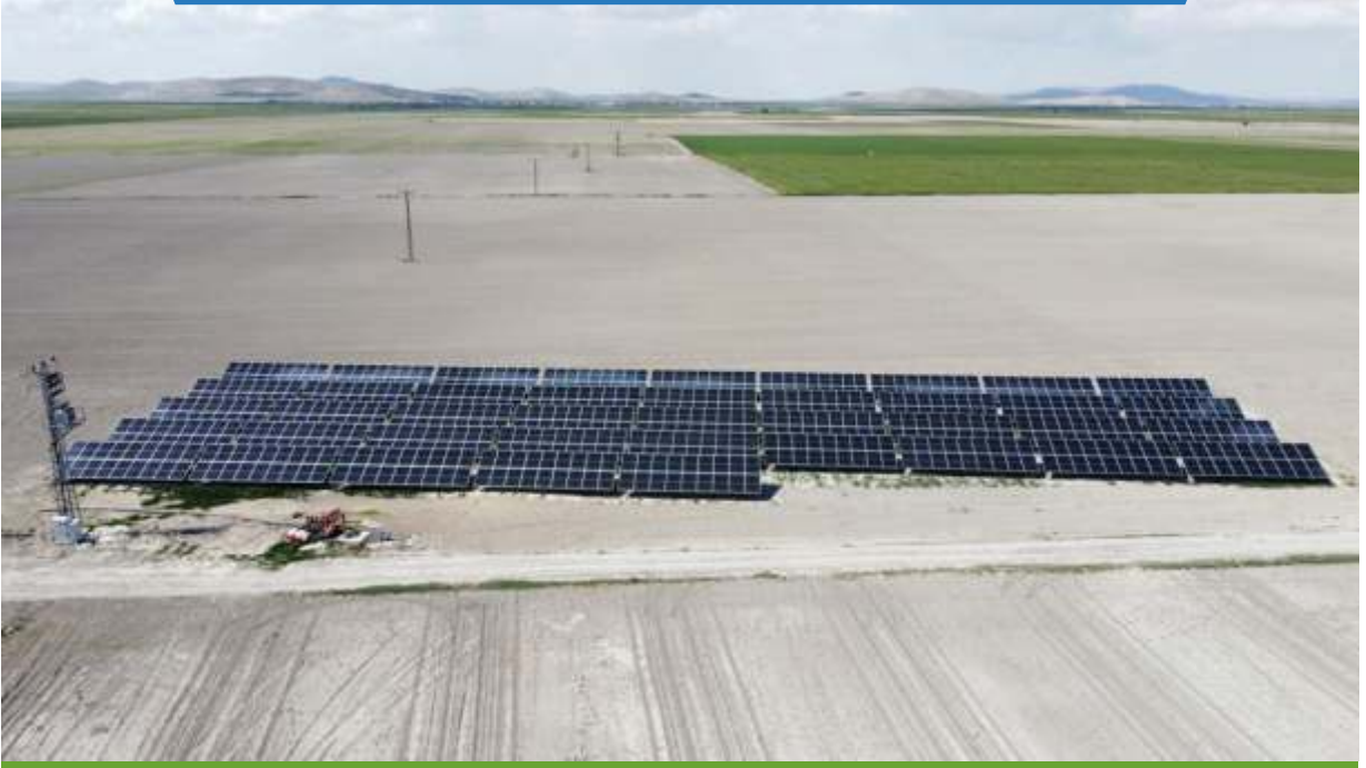
Necati Özgören | 352 kWp | KARAMAN - Osmaniye
