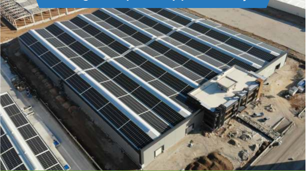
Yemsa Değirmen 2 | 2690 kWp | KONYA - Selçuklu
