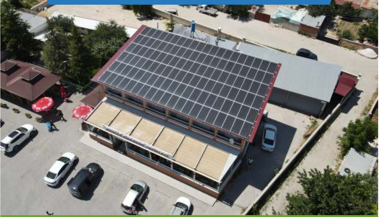
Ali Koç Restoran | 48 kWp | KONYA - Ilgın
