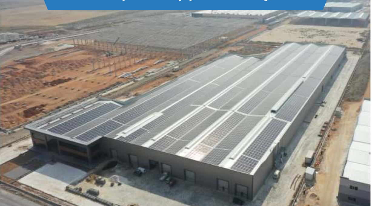
Process | 3490 kWp | KONYA - Selçuklu
