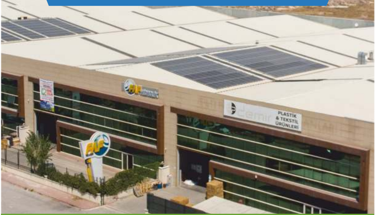
Faf Hidrolik | 90 kWp | KONYA - Karatay
