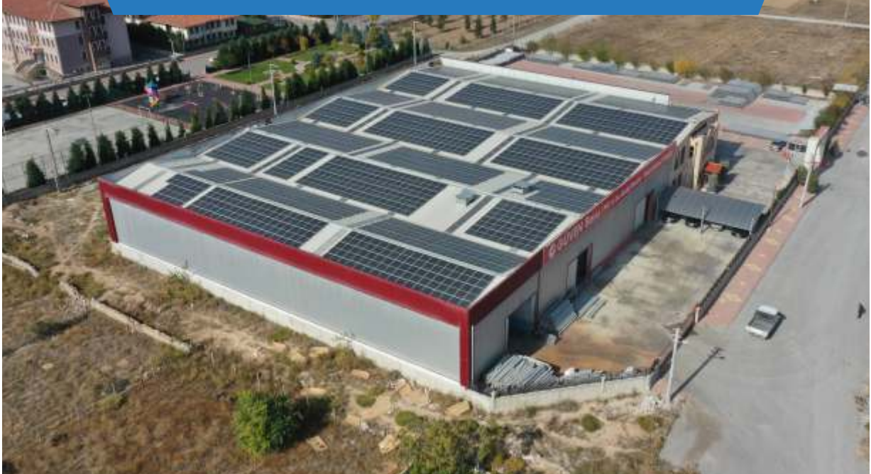
Güven Boru | 500 kWp | KONYA - Karatay
