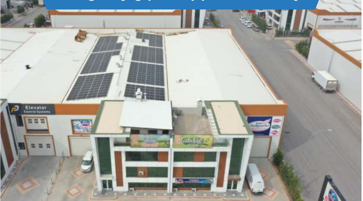
Akdağ Tereyağı | 114 kWp | KONYA - Karatay
