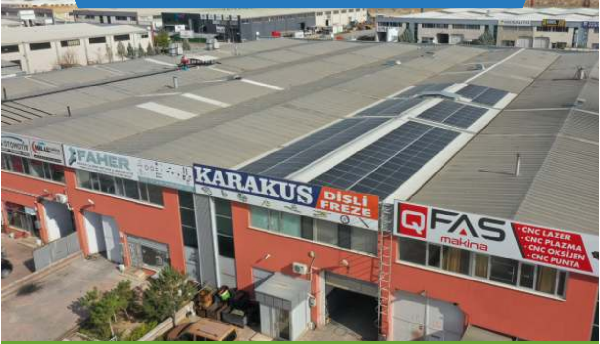
Karakuş Dişli | 60 kWp | KONYA - Karatay
