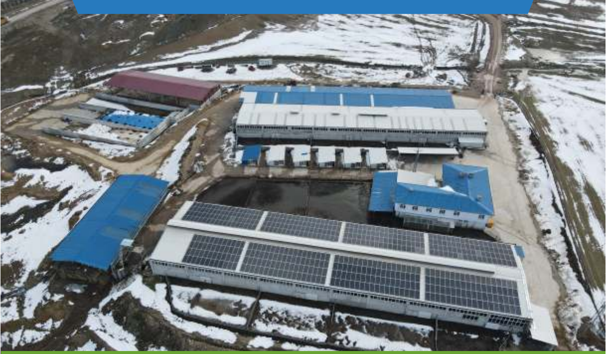
H.Hüseyin Yangöz Çiftlik | 220 kWp | KONYA - Sarayönü
