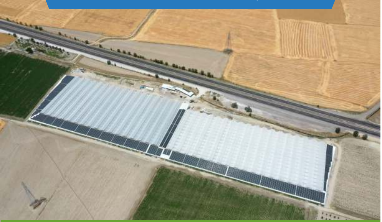
İhya Tarım - Sera GES | 1148 kWp | NEVŞEHİR - Ürgüp
