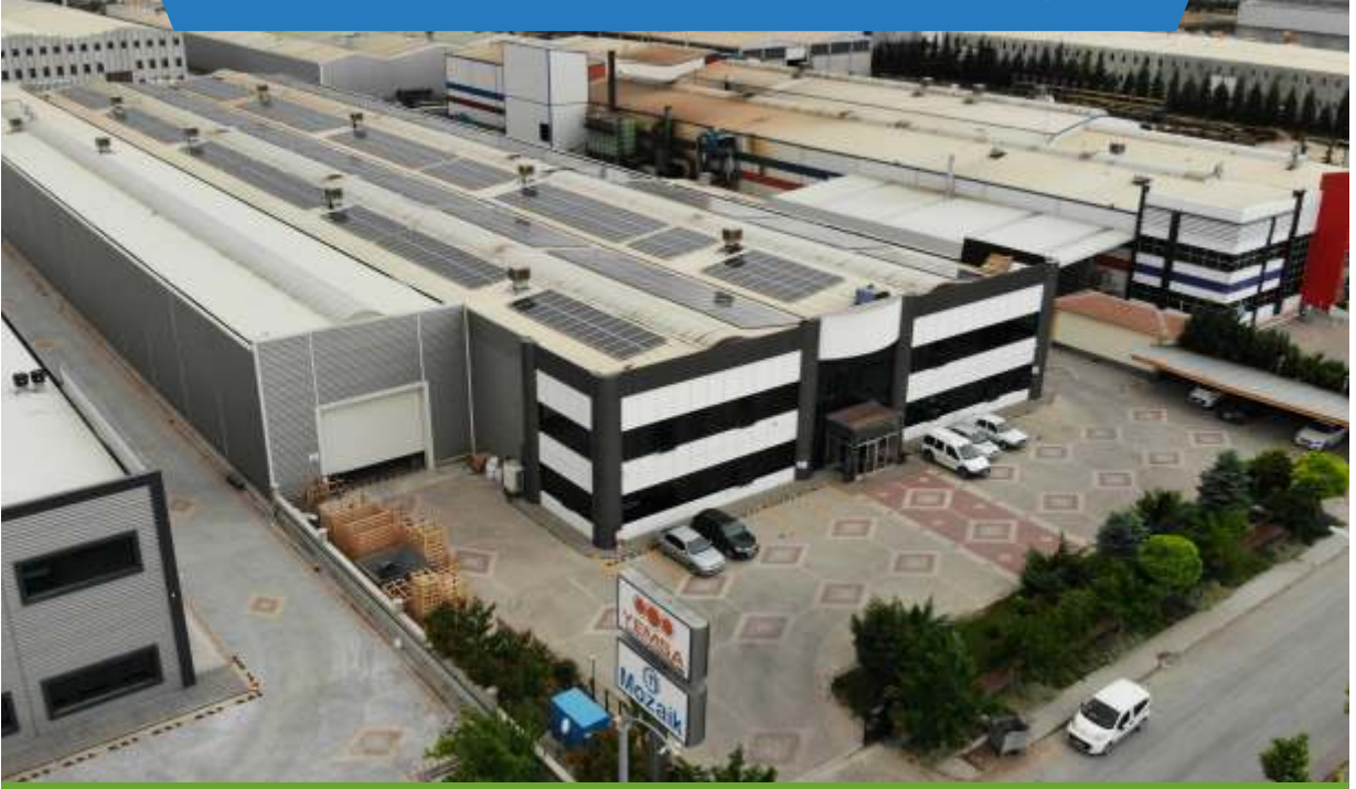
Yemsa Değirmen | 520 kWp | KONYA - Selçuklu
